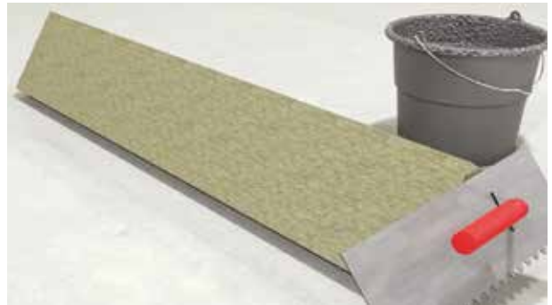
2 Нанесение клеевой смеси на тыльную поверхность PAROC CGL 20 су с помощью зубчатого шпателя.
